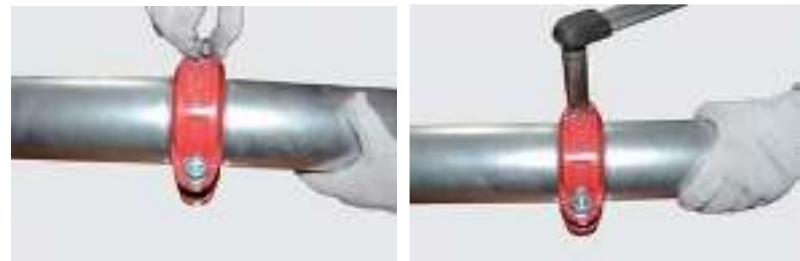
Рис.3. Грувлочное соединение гибкой муфтой.
